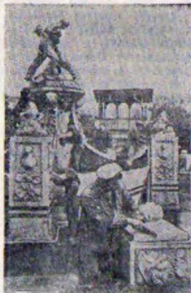
На снимке: ремонт фонтана в городском саду
